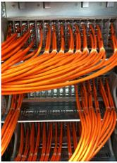
Bei Multimode-Fasern kann sich ein einzelnes Lichtsignal über mehrere Wege (engl. Mode) ausbreiten, bis es am Ende der Faser angekommen ist.
